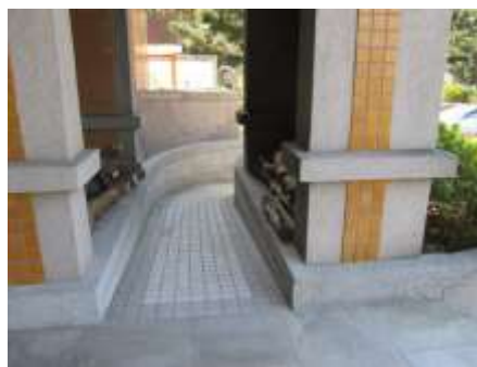
障礙坡道設施良好
