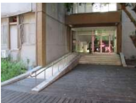
B 棟無障礙坡道設施良好
