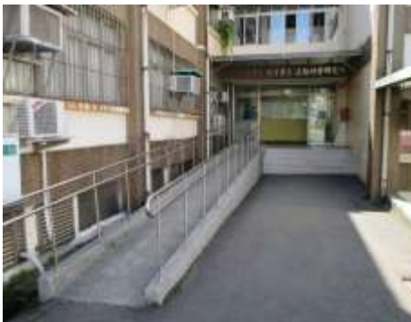
無障礙坡道設施良好
