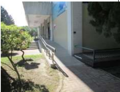
無障礙坡道設施良好
