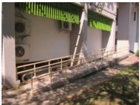
無障礙坡道設施良好
