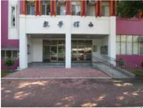
無障礙坡道設施良好
