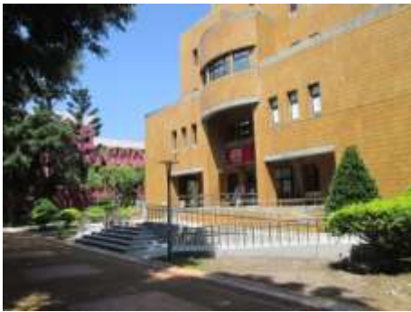
無障礙坡道設施良好
