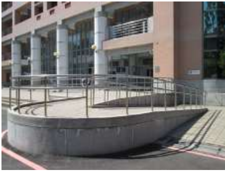
無障礙坡道設施良好
