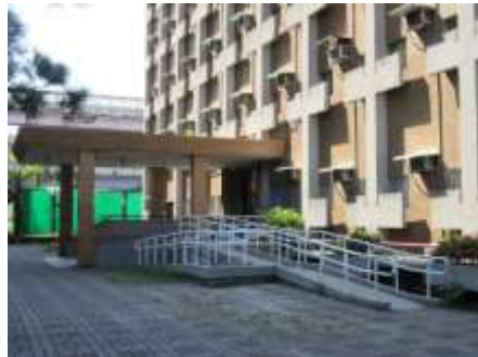
無障礙坡道設施良好
