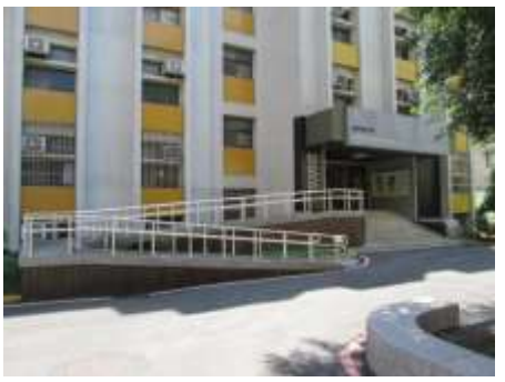
無障礙坡道設施良好
