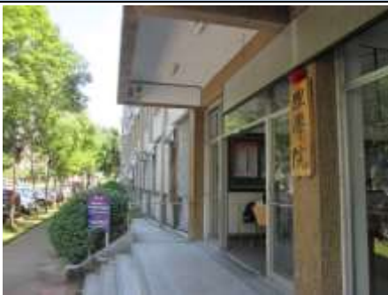
A 棟無障礙坡道設施良好
