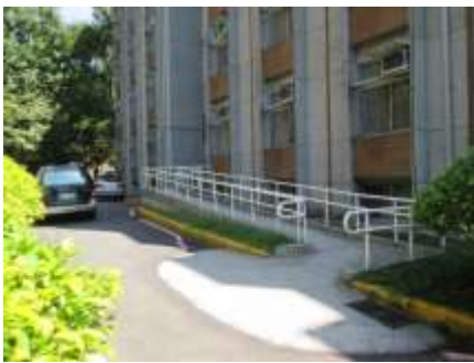
無障礙坡道設施良好
