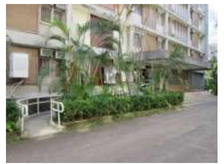
無障礙坡道設施良好
