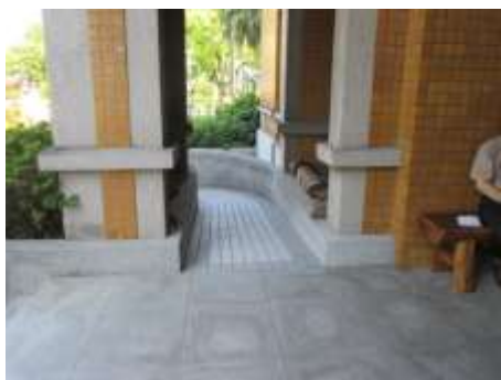
障礙坡道設施良好
