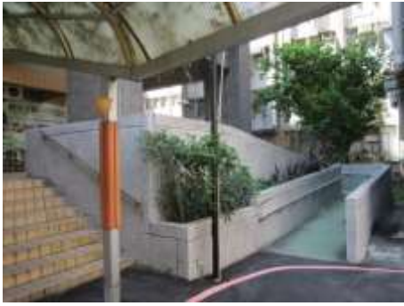
無障礙坡道設施良好
